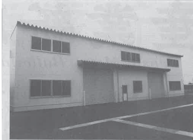
完成した第2工場
